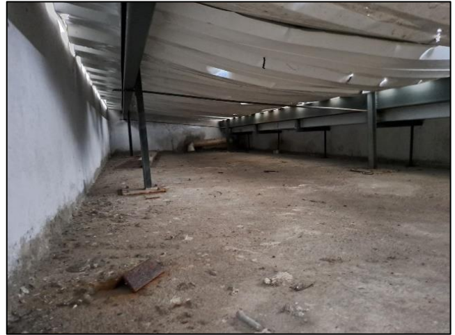
Foto 06: Estrutura metálica de sustentação.
