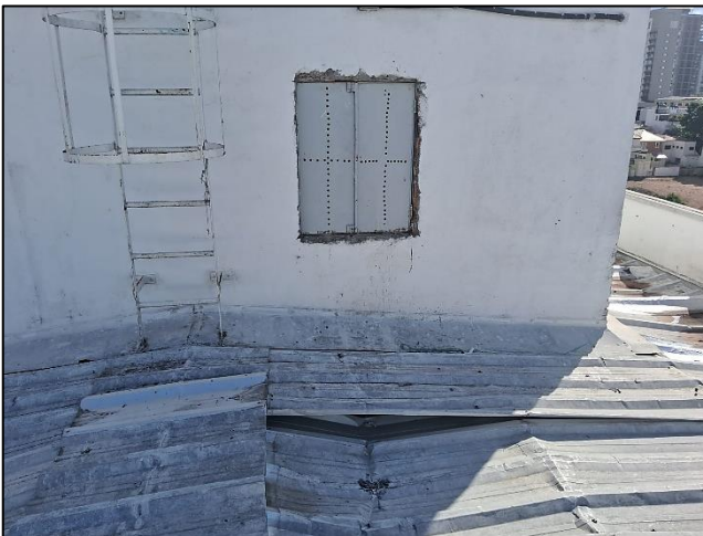
Foto 07: Porta de entrada para a cobertura.
