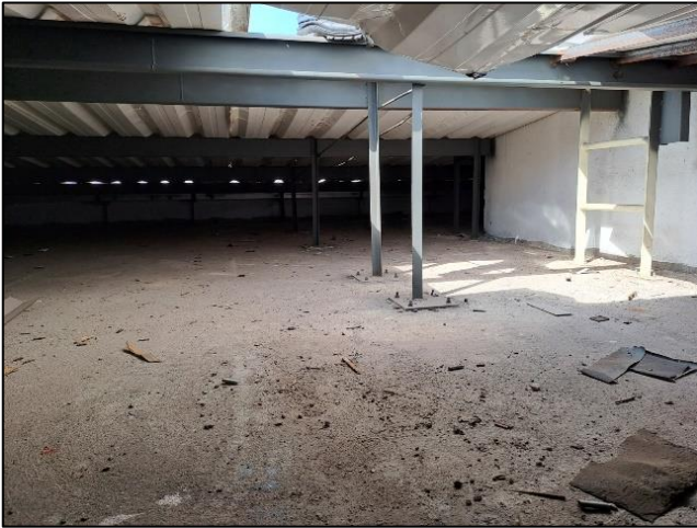
Foto 05: Interior da cobertura, acesso da escada.
